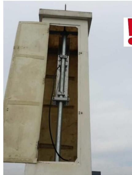
*Рис. В.5 – Антенна помещена в защитный корпус с металлическими остовами*
