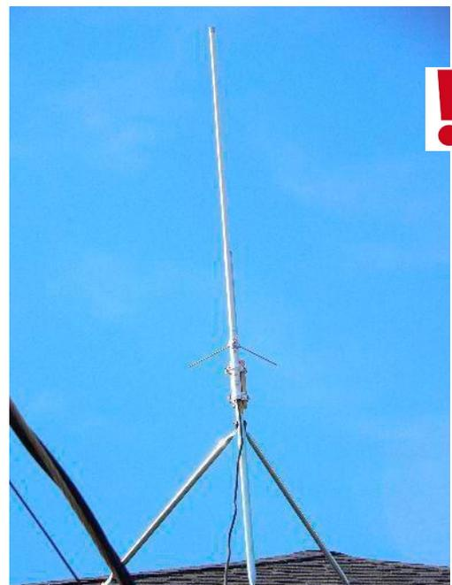
*Рис. В.3 – Антенна наклонена на покатой крыше*
