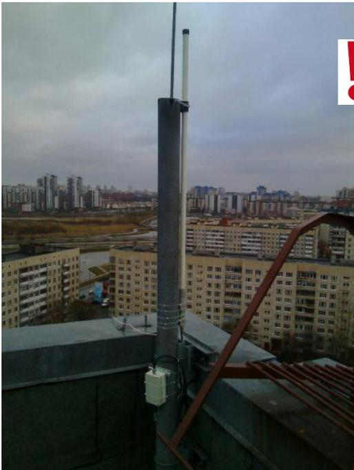
*Рис. В.6 – Мачта и молниеотвод закрывают антенну, антенна расположена слишком низко*
