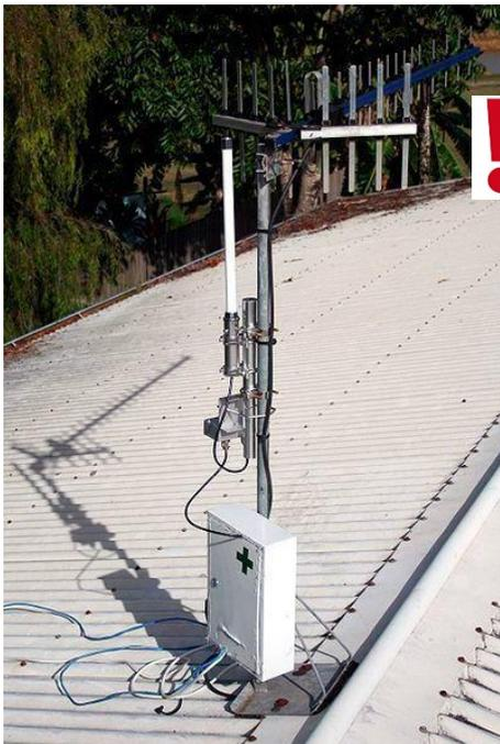
*Рис. В.2 – ТВ-антенна и мачта искажают диаграмму направленности антенны*
