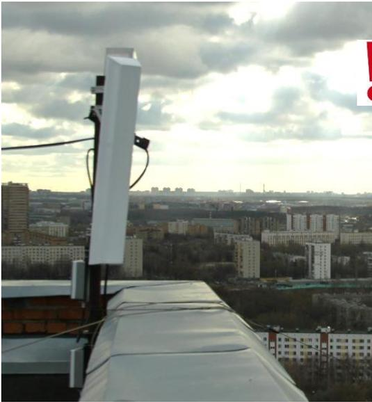
*Рис. В.4 – Антенна установлена слишком близко к парапету (нижняя часть диаграммы направленности антенны срезается)*
