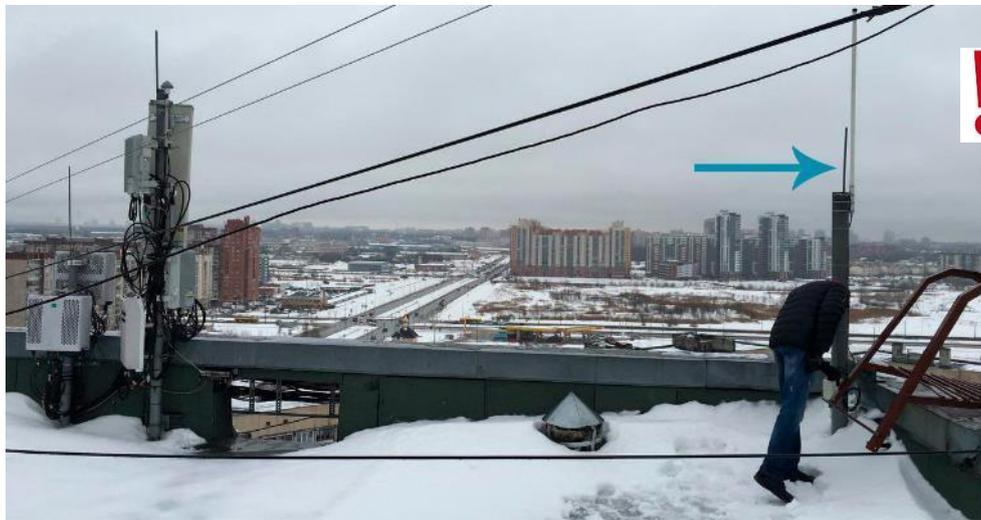
*Рис. В.1 – Прут молниеотвода искажает диаграмму направленности антенны*
